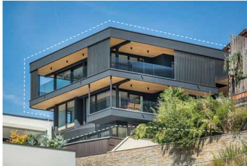
Ein Zubau in Holz bietet einen unmittelbaren Vorteil für die Bewohner des zu erweiternden Hauses: Die Bauarbeiten erfolgen in Trockenbauweise – die Auswirkungen auf die Wohnqualität sind bedeutend geringer betreffend der Lärm- und Staubbelastung. Außerdem kann die Bauphase durch kurze Bauzeiten verkürzt werden, ein Vorteil vor allem dann, wenn das Bestandsgebäude auch während der Bauzeit bewohnt wird.
