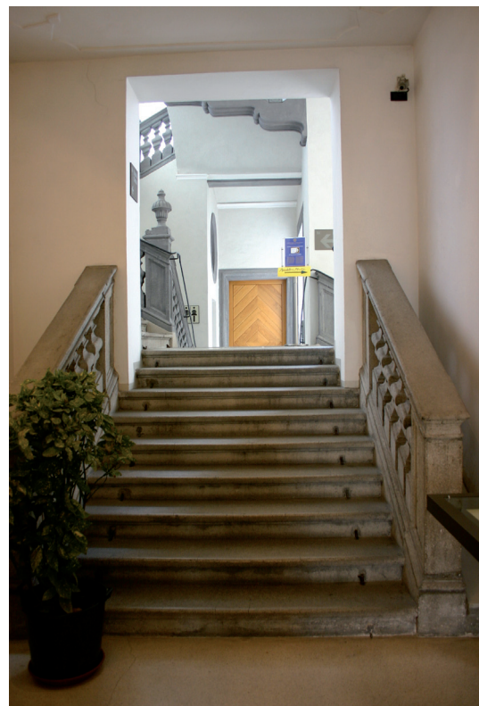
Die Gänge und Treppen des Merkantilgebäudes sind an die Bestimmungen im Brandschutzbereich angepasst worden.
