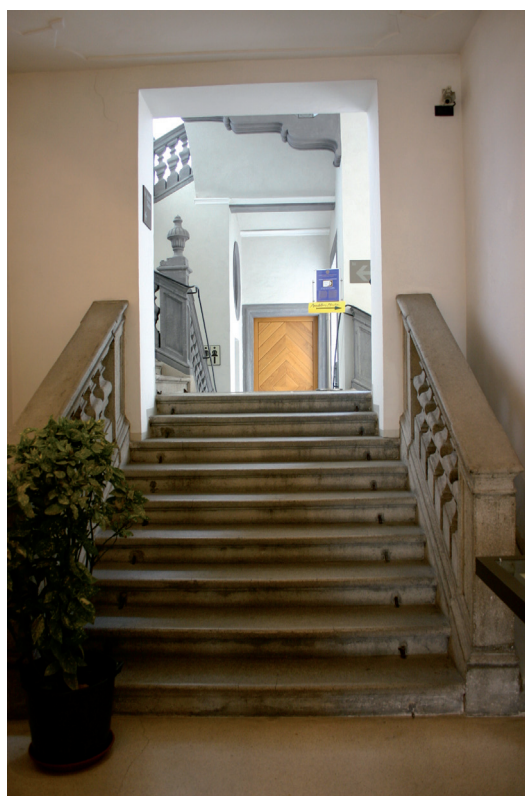
I corridoi e le scale nel Palazzo Mercantile sono stati adeguati alla normativa in materia di prevenzione incendi.
